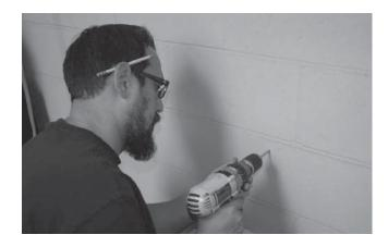
8. Просверлите отверстия для дюбелей с помощью дрели и сверла 5/16 дюймов.
