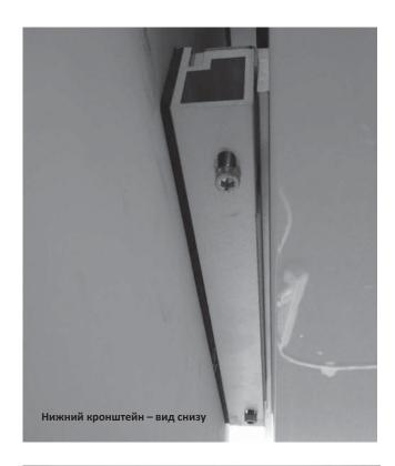
22. Закрепите нижний кронштейн снизу двумя 50-мм монтажными винтами.
