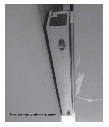
19. Закрепите нижний кронштейн снизу двумя 50-мм монтажными винтами.
