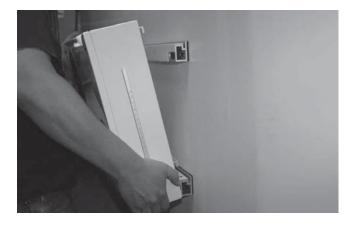
17. Подсоедините входящий в комплект кабель питания к разъёму на задней панели Habitat1. Поднимите сабвуфер и наденьте его на кронштейны.
